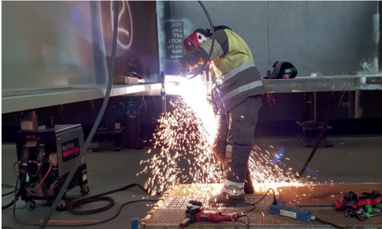
Afbranden lasuitloper dwarsdrager tegen een onderflens hoofdligger met een mal
