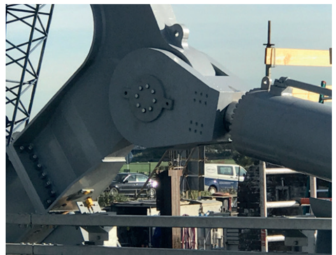
Zijaanzicht draaipunttoeg gaffelverbinding (foto's: Ronald Geijzen, Movares)
