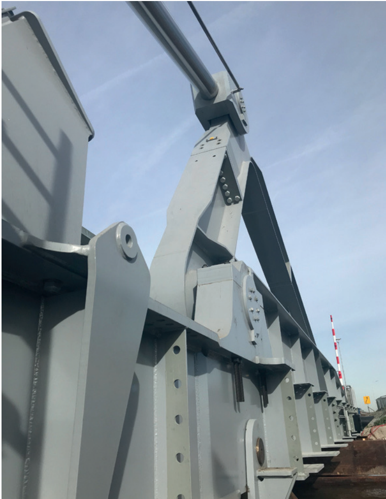
Plaatdikteovergang draaipunttoeg naar profieldoorsnede tpv boutverbinding
