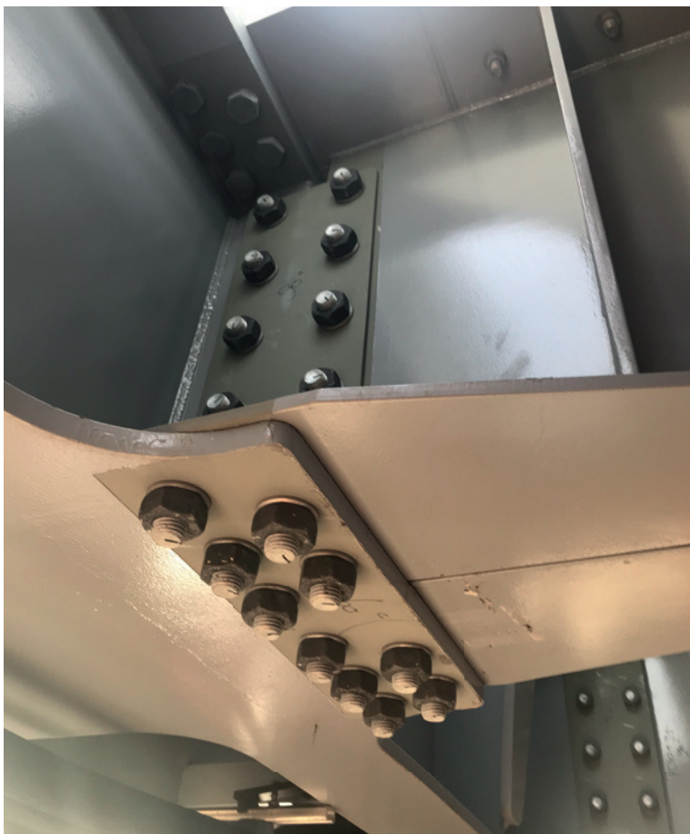
Boutverbinding van rijvloersecties aan de landhoofdmodule
