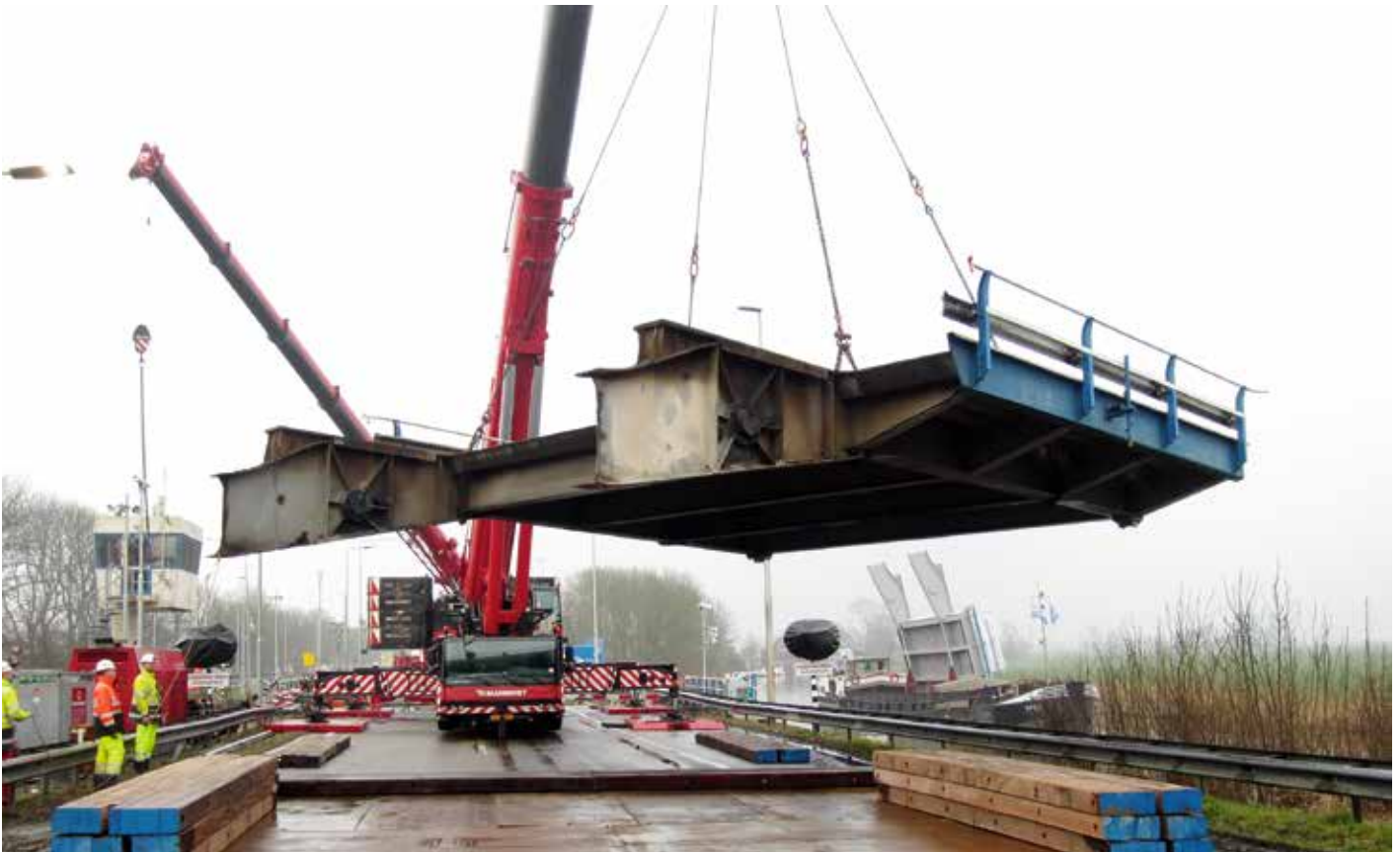
Oud val tijdens vervanging Kruiswaterbrug, met vier dwarsdragers.
