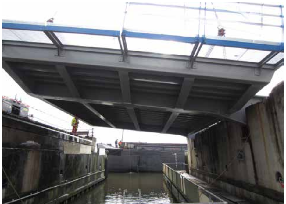
Gerenoveerd val Kruiswaterbrug, met vijf dwarsdragers en inspectiepad met roosters.
