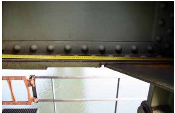
11. Locatie van de metingen. Profiel achter is de cross beam, rechts de main girder. Foto rechts: close up onderflens cross beam.
