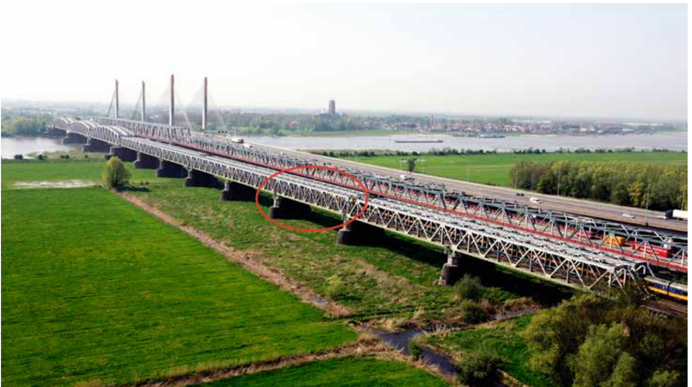
1. Brug over de Waal. Het rood gemarkeerd deel is case study voor het versterken van een stalen spoorbrug met stalen deksecties.
