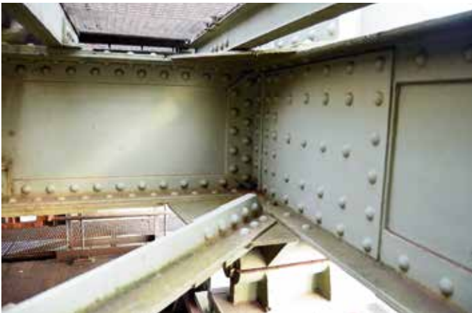
11. Locatie van de metingen. Profiel achter is de cross beam, rechts de main girder. Foto rechts: close up onderflens cross beam.
