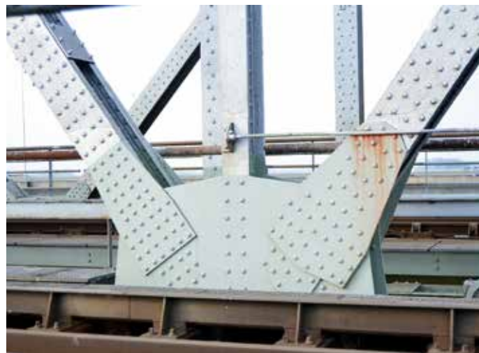
3. Verbinding vakwerkligger.
