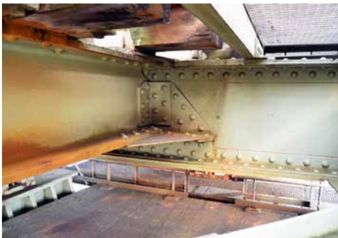
4. Verbinding langsligger-dwarsdrager.
