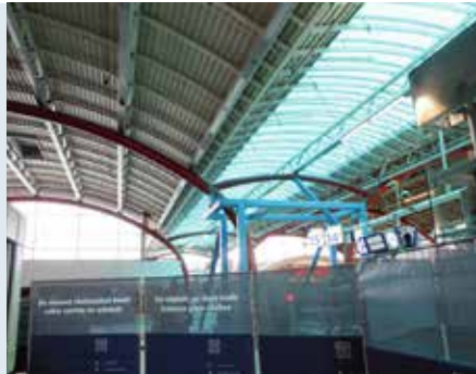
...worden opgevangen door een 'hoefijzerportaal'.
