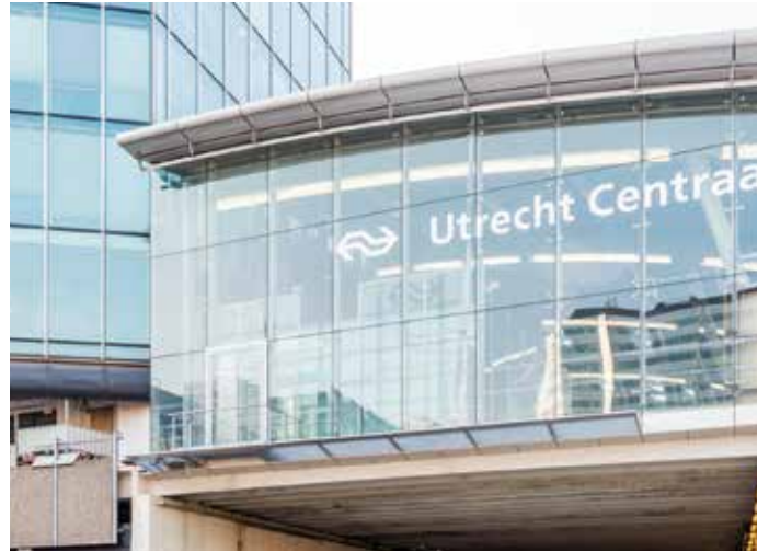
4. Rails voor de glazenwasinstallatie buiten.
