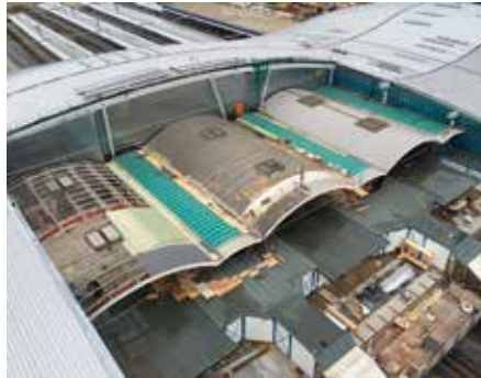
7. Het nieuwe station Utrecht Centraal tijdens de laatste bouwfase.
