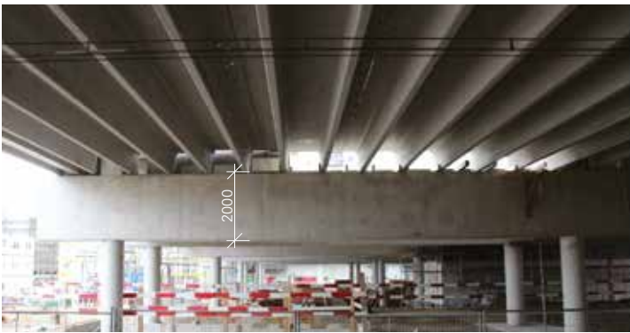
2. TT-platen en nietjes tijdens de bouw. De toelaatbare veranderlijke belasting van de bestaande vloer is 5,0 \text{ kN/m}^2 . De uitbreiding heeft dezelfde elementen, maar met een capaciteit van 7,0 \text{ kN/m}^2 .
