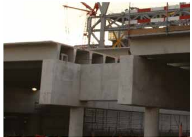
2. TT-platen en nietjes tijdens de bouw. De toelaatbare veranderlijke belasting van de bestaande vloer is 5,0 \text{ kN/m}^2 . De uitbreiding heeft dezelfde elementen, maar met een capaciteit van 7,0 \text{ kN/m}^2 .
