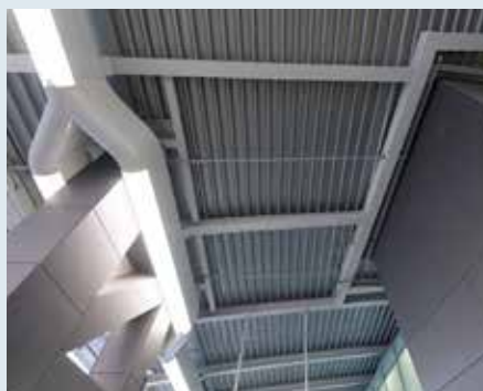
Raveling rond de vakwerkkolom.
