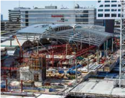
6. Het nieuwe station Utrecht Centraal tijdens een eerste bouwfase.
