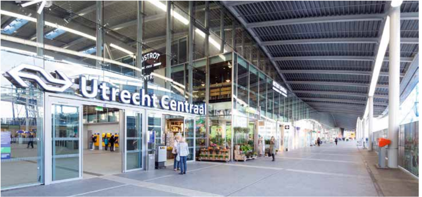
1. Via de interwijkverbinding kan men ongestoord van oost naar west oversteken of Utrecht CS binnengaan.
