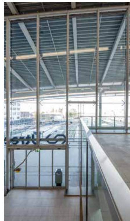
Ravelconstructie als horizontale bevestiging.
