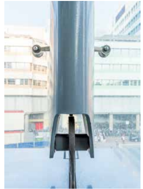
De contactdruk op de rvs-pen loopt op tot 100 MPa.
