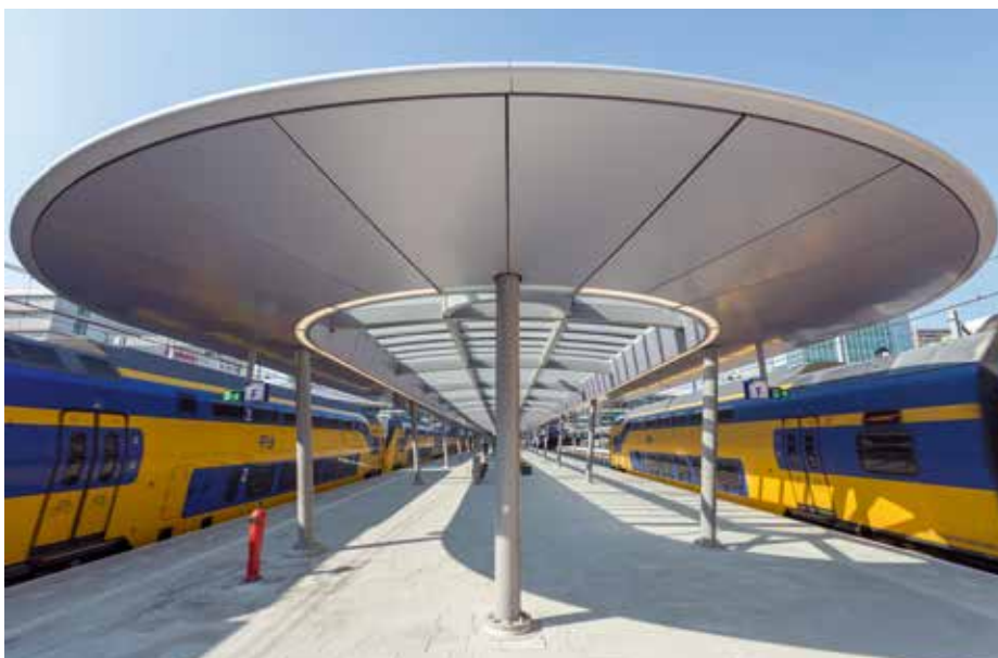
6. Aansluiting kap met OVT (boven). De kap zelf (onder) heeft een glazen middendeel en een aluminium randafwerking.
