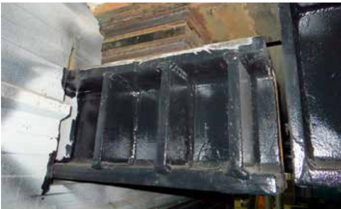
5. Console met drukvaste oplegging.
