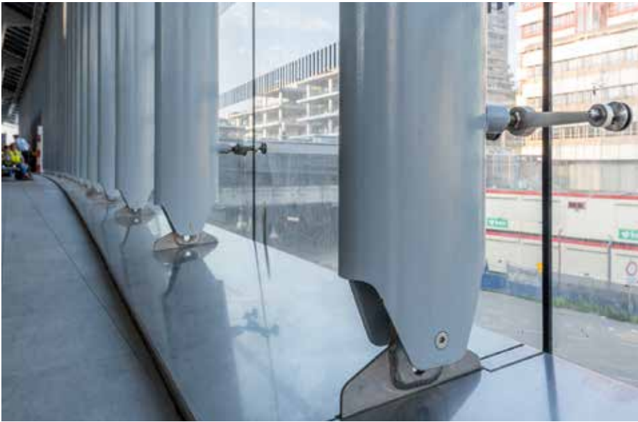
Oostgevel. De grote windbelasting wordt via de stijlen afgedragen aan de voeten en ophanging bovenin.
