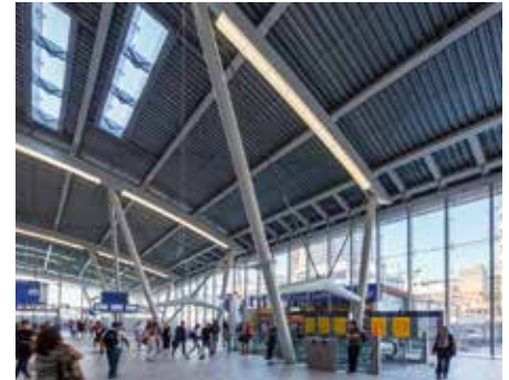
5. Stabiliteitsbokken (rechts) en schoorkolommen (links achter).
