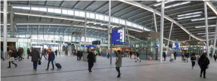
4. De 'lens' (vierendeelligger) in de kap zorgt voor extra daglichttoetreding
