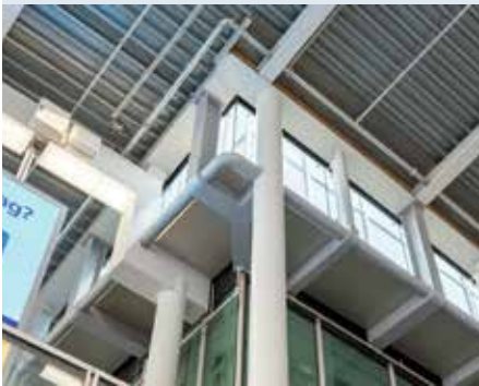
Gootconstructie bij de Katreinetooren.
