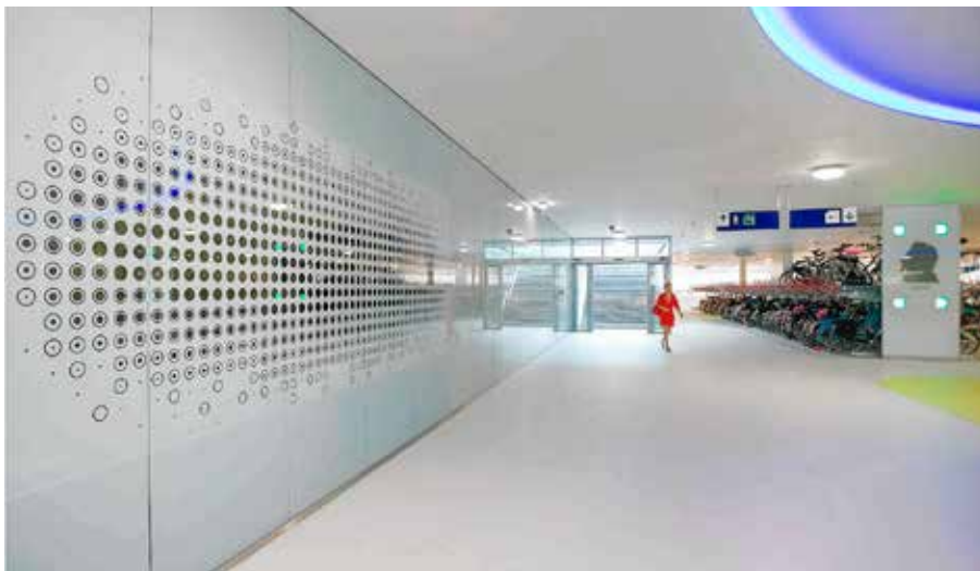
Fietsenstalling onder het Mahlerplein. (Bron: Movares)
