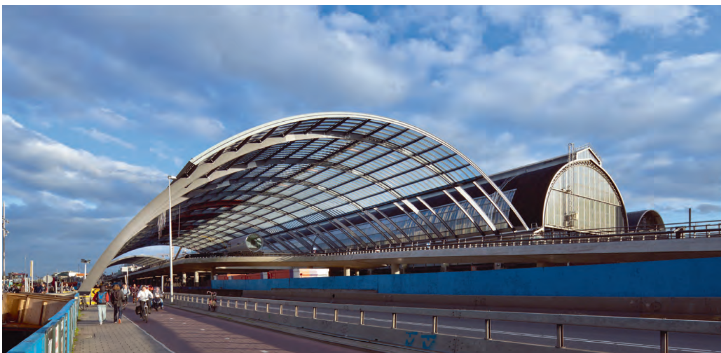
2. Visualisatie (boven) en overzicht (onder) van de constructie. De spanten zijn brandwerend gecoat tot de maximale vlamhoogte.
