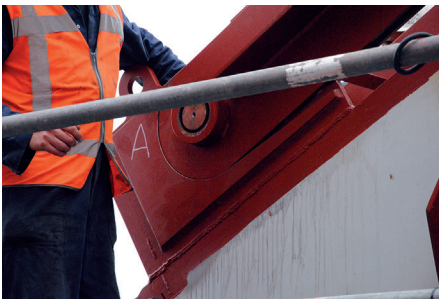
Een scharnierpen borgt de geleidingsconstructie.
