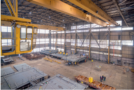
Prefabricage van de deksegmenten.
