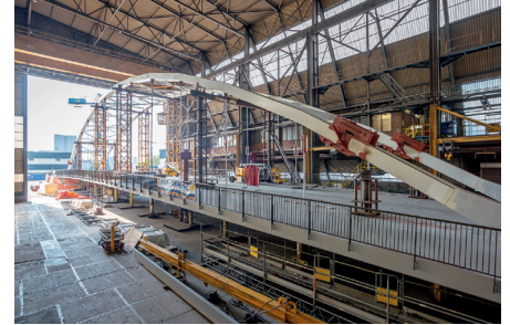
Voormontage van de hangers.
