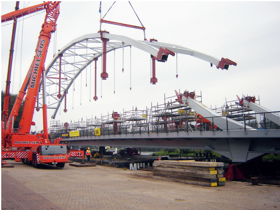
Het inhijzen van de boog is een kritiek moment . Voor de plaatsing zijn tijdelijke constructies aangebracht.
