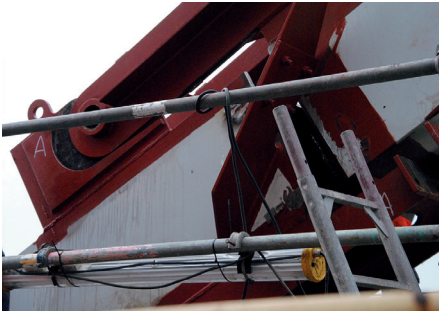
De boog komt onder eigen gewicht in de geleiding.
