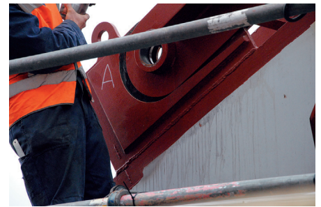
De afschuining mag namelijk niet beschadigd raken.
