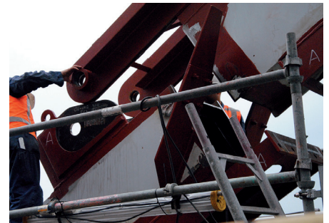
Een speciale constructie geleidt de boog naar positie.
