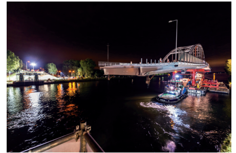
Plaatsing nieuwe brug op bestaande pijlers.
