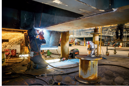
Laswerk aan fietspadconsole en hoofdlijger.
